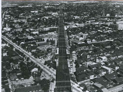
昭和8年に完成した蒲生～守口間(4.2km)の高架複々線
